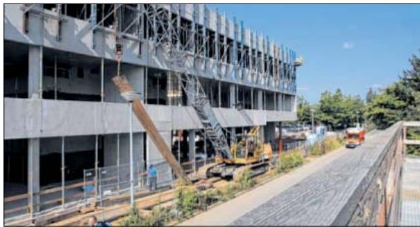
Der erste „Gebäude-Zwilling“ – das Hirnzentrum – wird im nächsten Monat Richtfest feiern.
